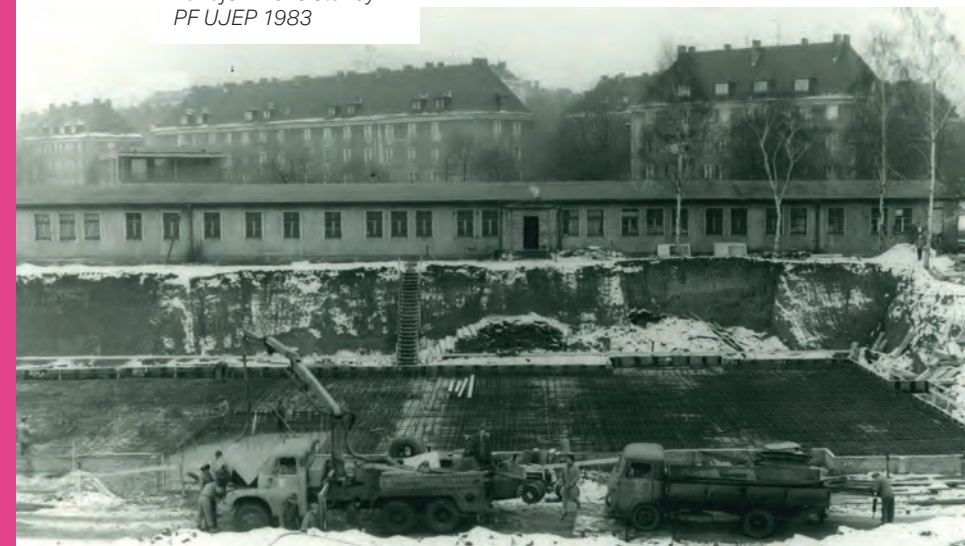
Zahájení nové stavby PF UJEP 1983
